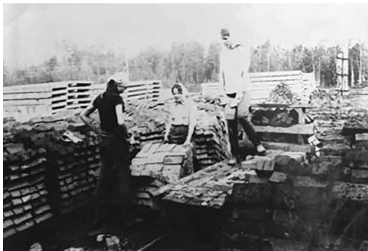
Да... Укладка кирпичей дело непростое
